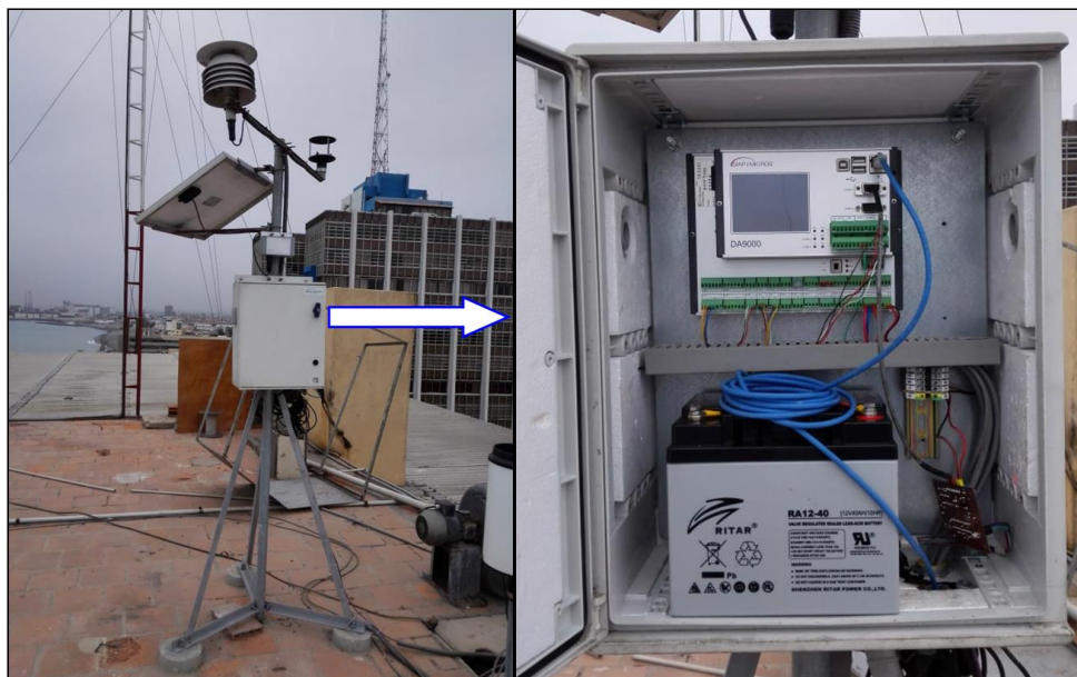
Estación meteorológica CALLAO del IMARPE (a la derecha) y ubicación del data logger DA9000 que recibe los datos emitidos por el sensor ubicado en el muelle de IMARPE.
