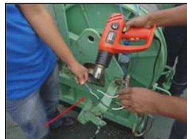
*Figura 1: Renovación de conexiones y empalmes del cable de comunicación de la roseta*
